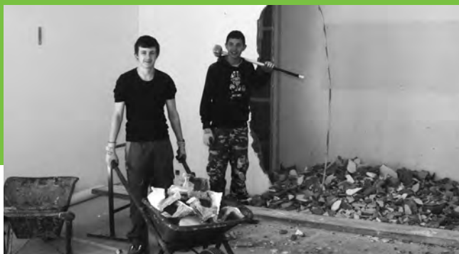
Le premier coup de pioche pour démolir un mur, un grand plaisir pour les jeunes.
